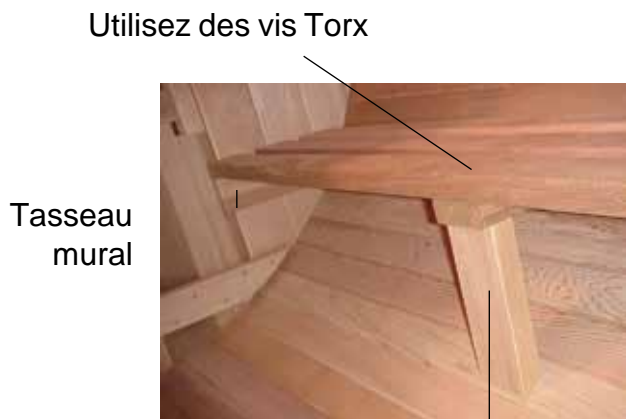
Figure 5 - Installation des sièges
