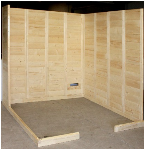
8 vis 6 x 120 mm par montant d'angle
