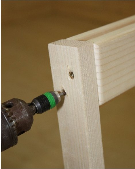
Transportleiste vom Türstock entfernen
