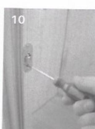
Si nécessaire, vous pouvez ajuster le cylindre de blocage en faisant tourner la vis qui se trouve en dessous à l'aide d'un tournevis comme le montre l'illustration 10.
